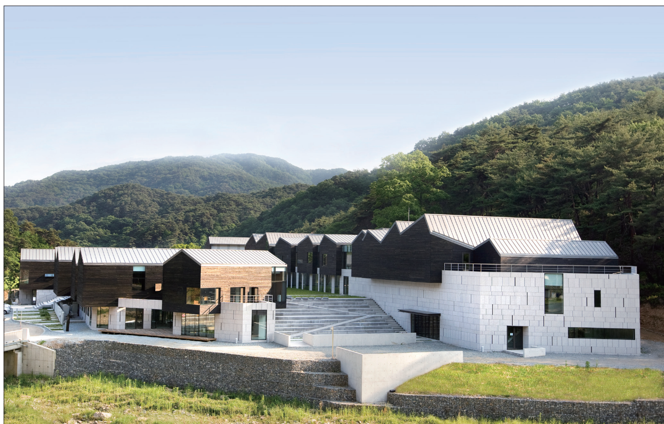
2009년 6월에 개원한 한국문화연수원은 우리나라 내로라하는 건축가 중 한명인 승효상씨가 자연을 거스르지 않는 친환경 신개념 건축물로 건립해 당시 건축계 새로운 바람을 일으켰다. 연수원 건축양식은 한국건축사에 한 획을 그었다.
